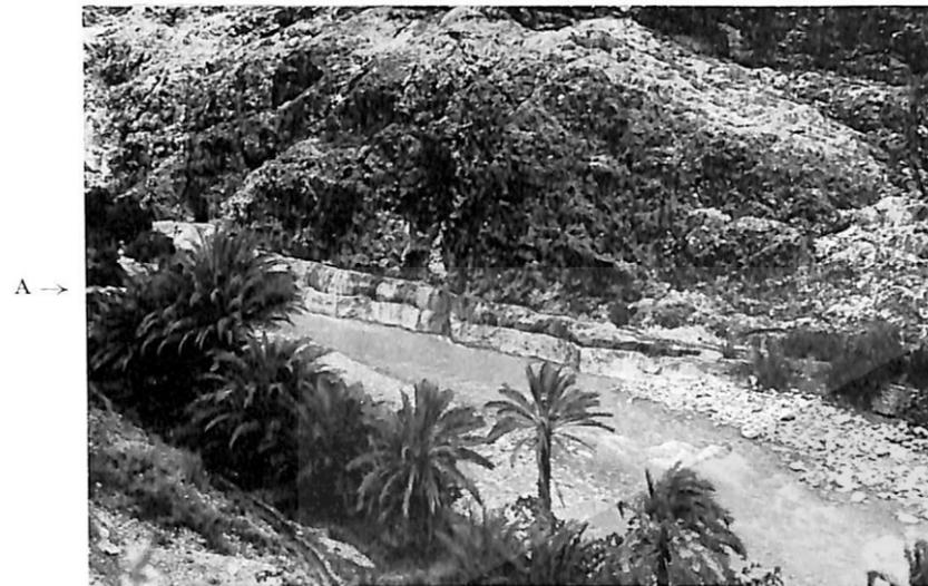
FIG. 4. — Canalisation antique dans le lit de l'Oued Abdi ; la canalisation antique taillée dans le roc (A) est surplombée par une canalisation plus récente en pierres de petit appareil.
